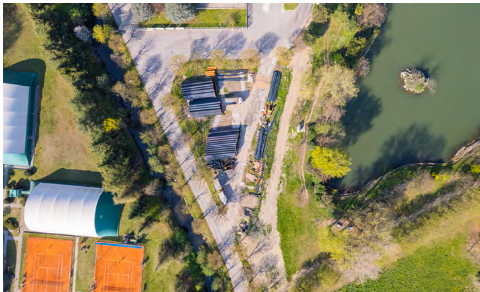
Posa dell'Acquedotto Brianteo, Valmadrera. Foto di Matteo Colombo.
