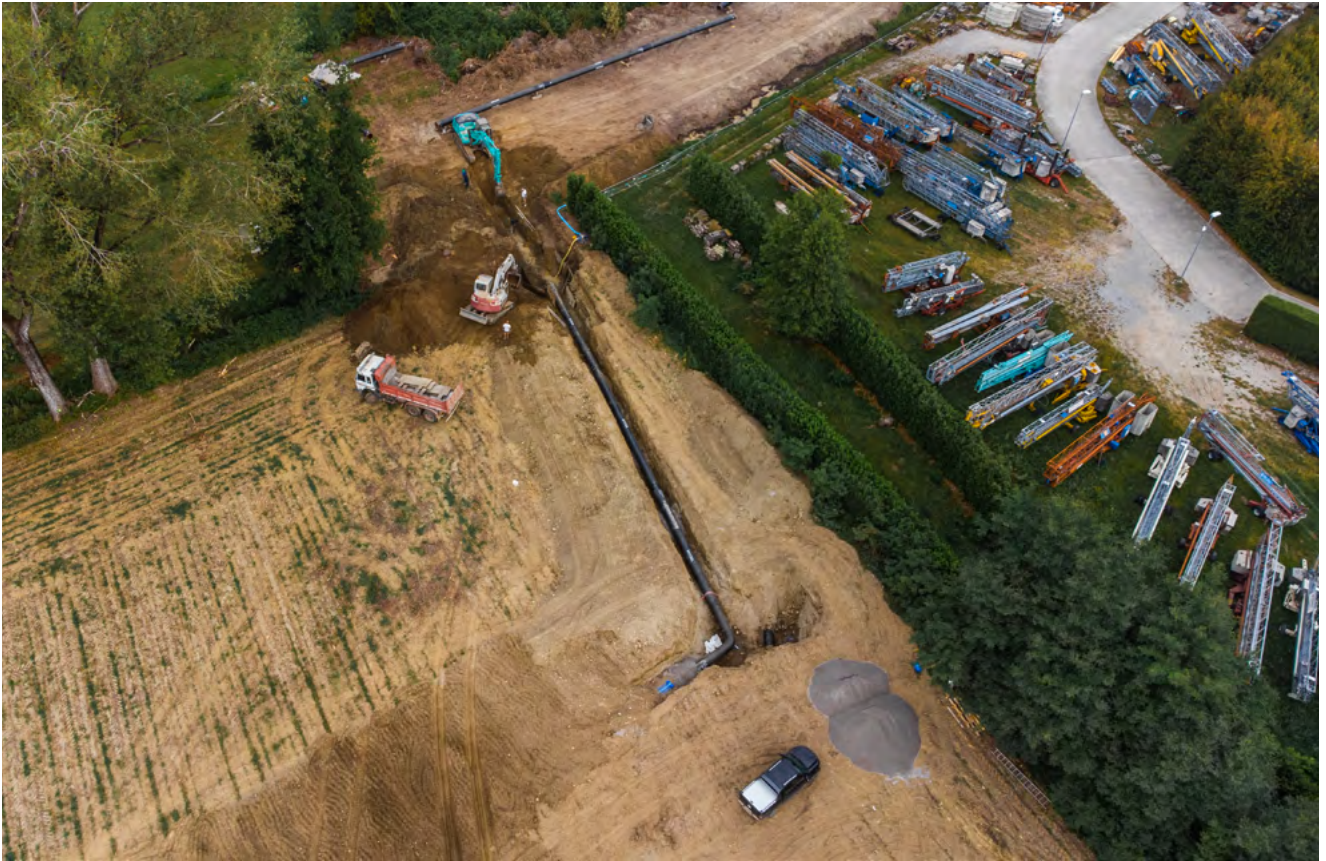
Raddoppio dell'Acquedotto Brianteo, Dolzago. Foto di Matteo Colombo.
