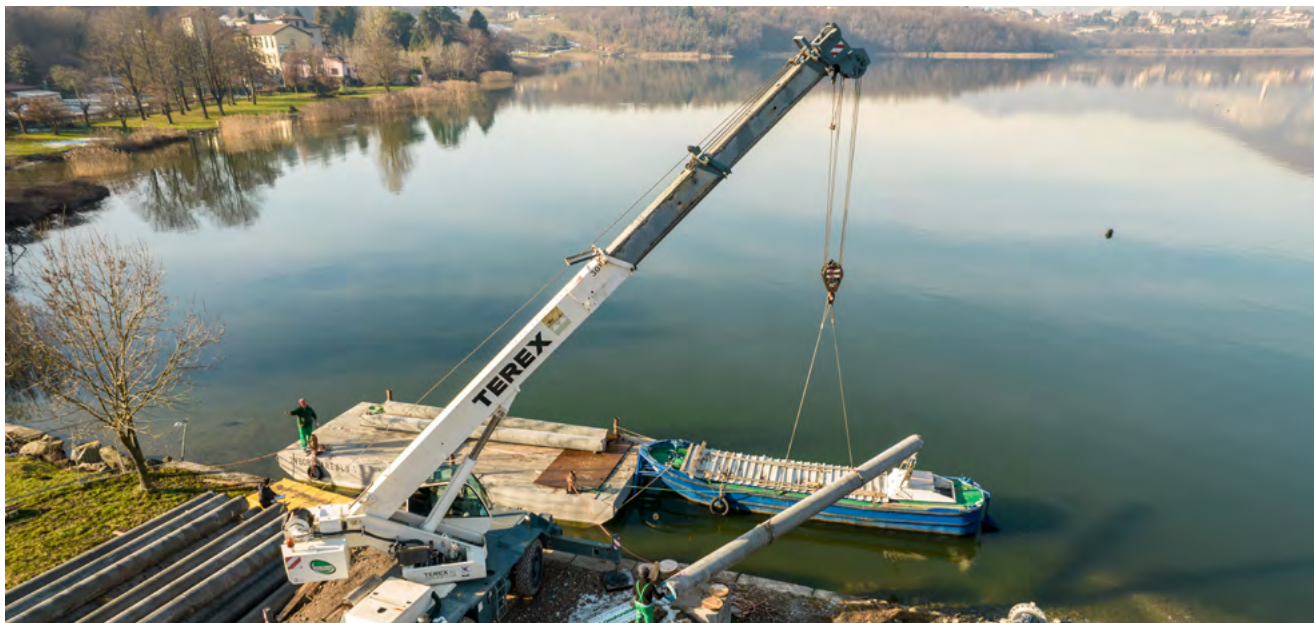
Varo della tratta sublacuale dell'Acquedotto Brianteo, Lago di Annone. Foto di Matteo Colombo.
