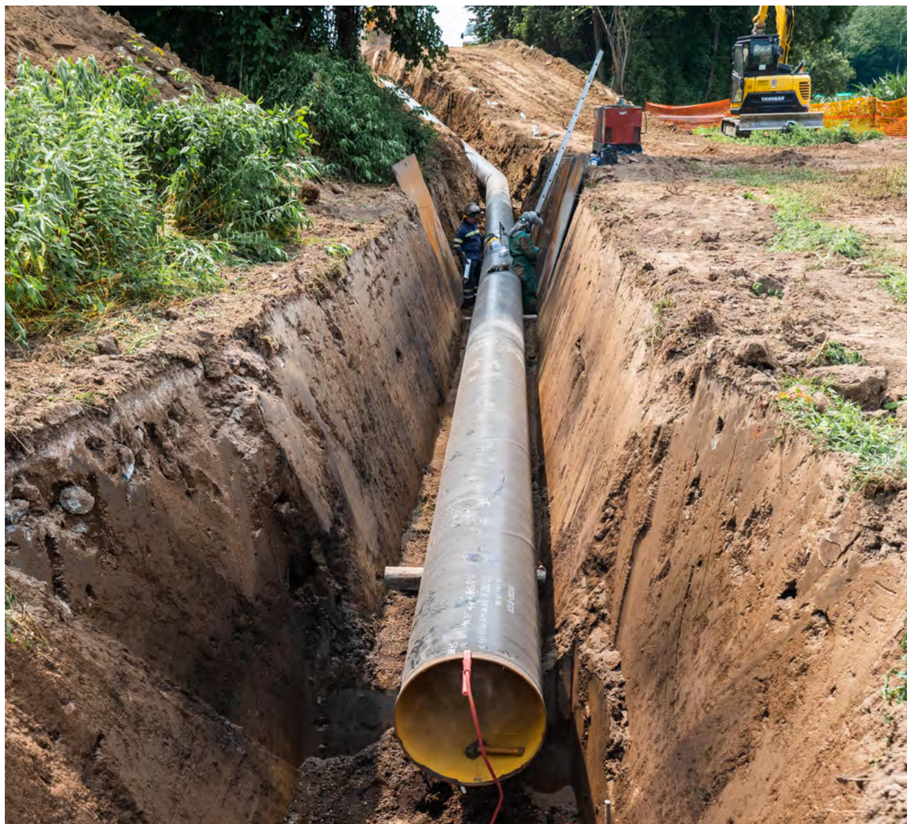
Raddoppio dell'Acquedotto Brianteo, Dolzago. Foto di Matteo Colombo.
