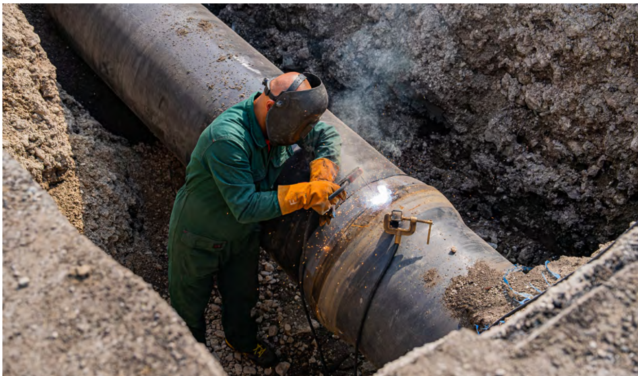
Raddoppio dell'Acquedotto Intercomunale Brianteo, Valmadrera. Foto di Matteo Colombo.
