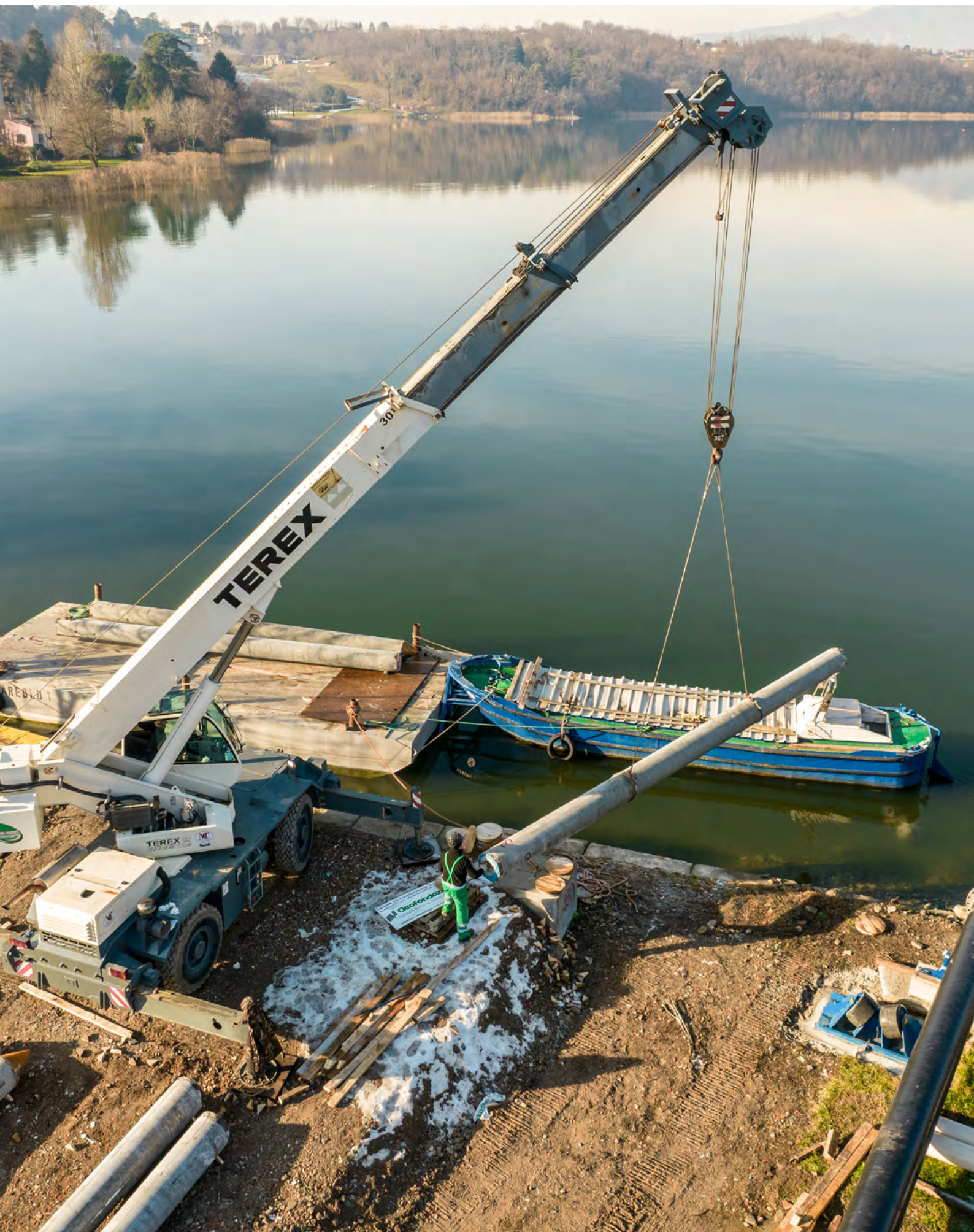
Varo della tratta sublacuale dell'Acquedotto Brianteo, Lago di Annone. Foto di Matteo Colombo.
