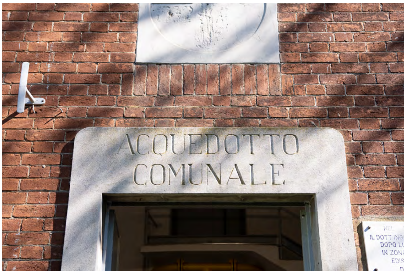
Serbatoio Monterobbio, Robbiate. Foto di Matteo Colombo.
