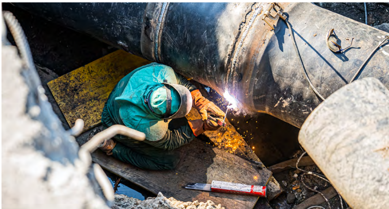
Raddoppio dell'Acquedotto Intercomunale Brianteo, Valmadrera. Foto di Matteo Colombo.
