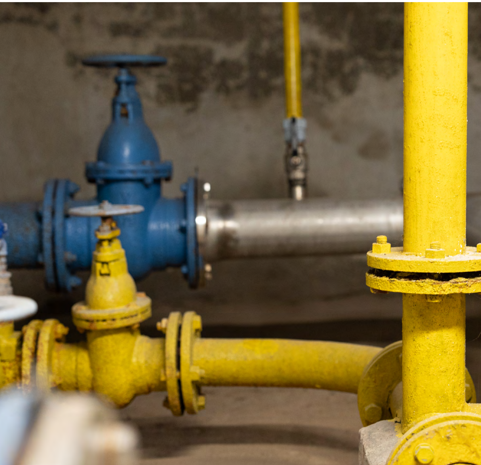
Serbatoio Monterobbio, Robbiate. Foto di Matteo Colombo.
