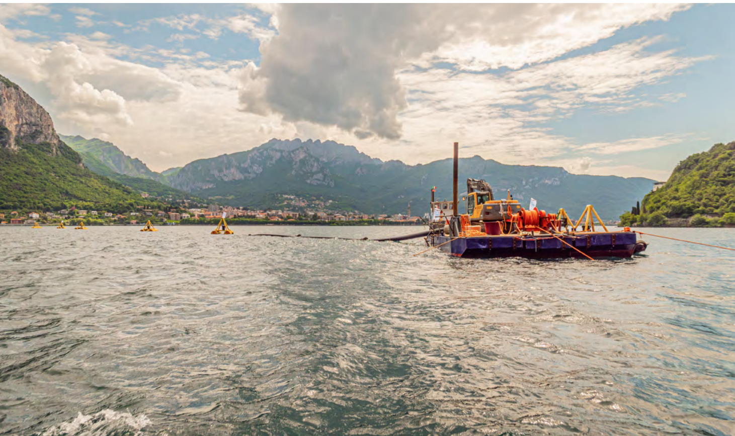
Varo della tratta sublacuale del collettore fognario a Onno. Foto di Matteo Colombo.
