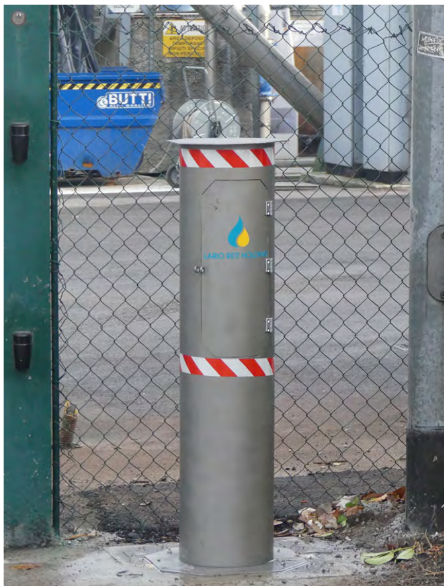
Colonnina per il riuso di acqua non potabile a Lecco. Foto di Silea.
