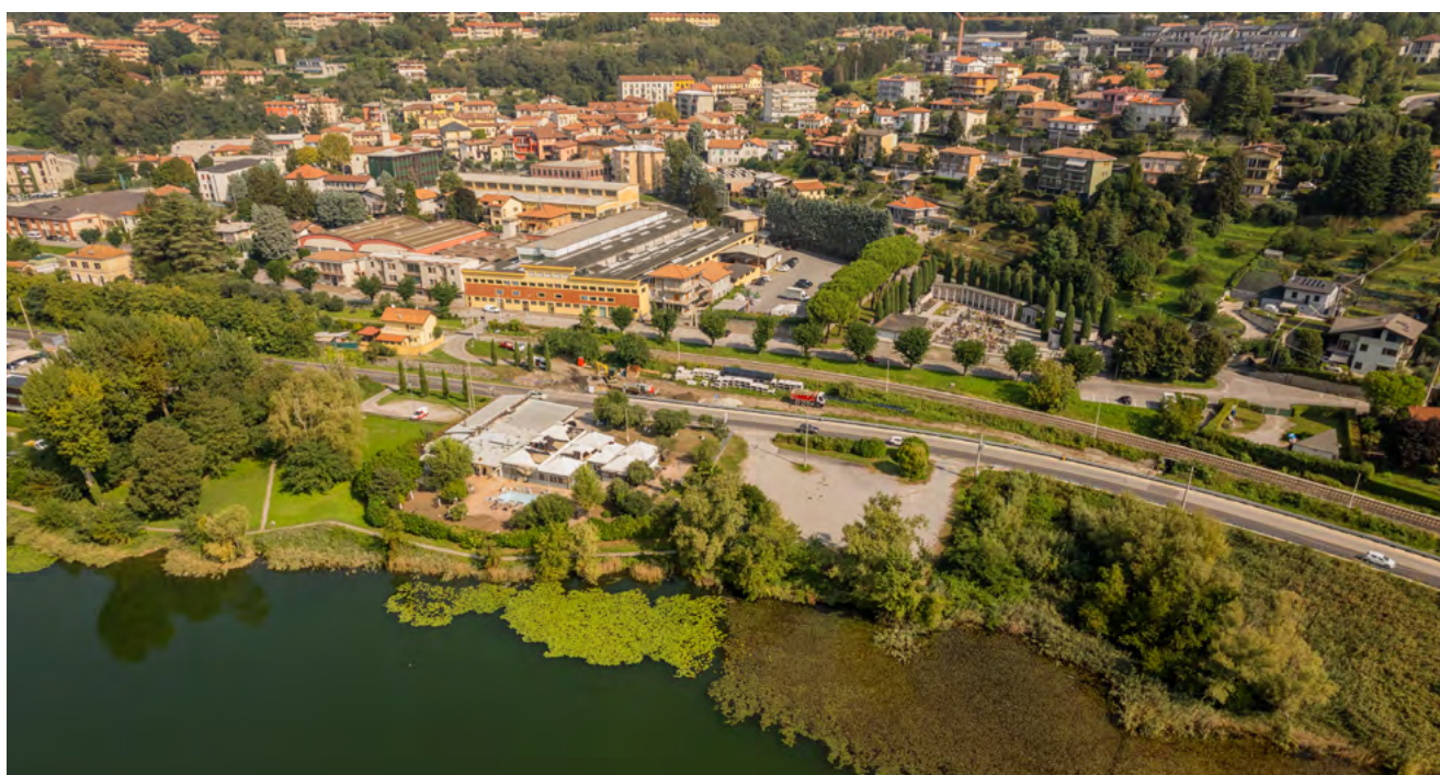
Ripristino del collettore fognario intercomunale Annone-Oggiono, Galbiate. Foto di Matteo Colombo.
