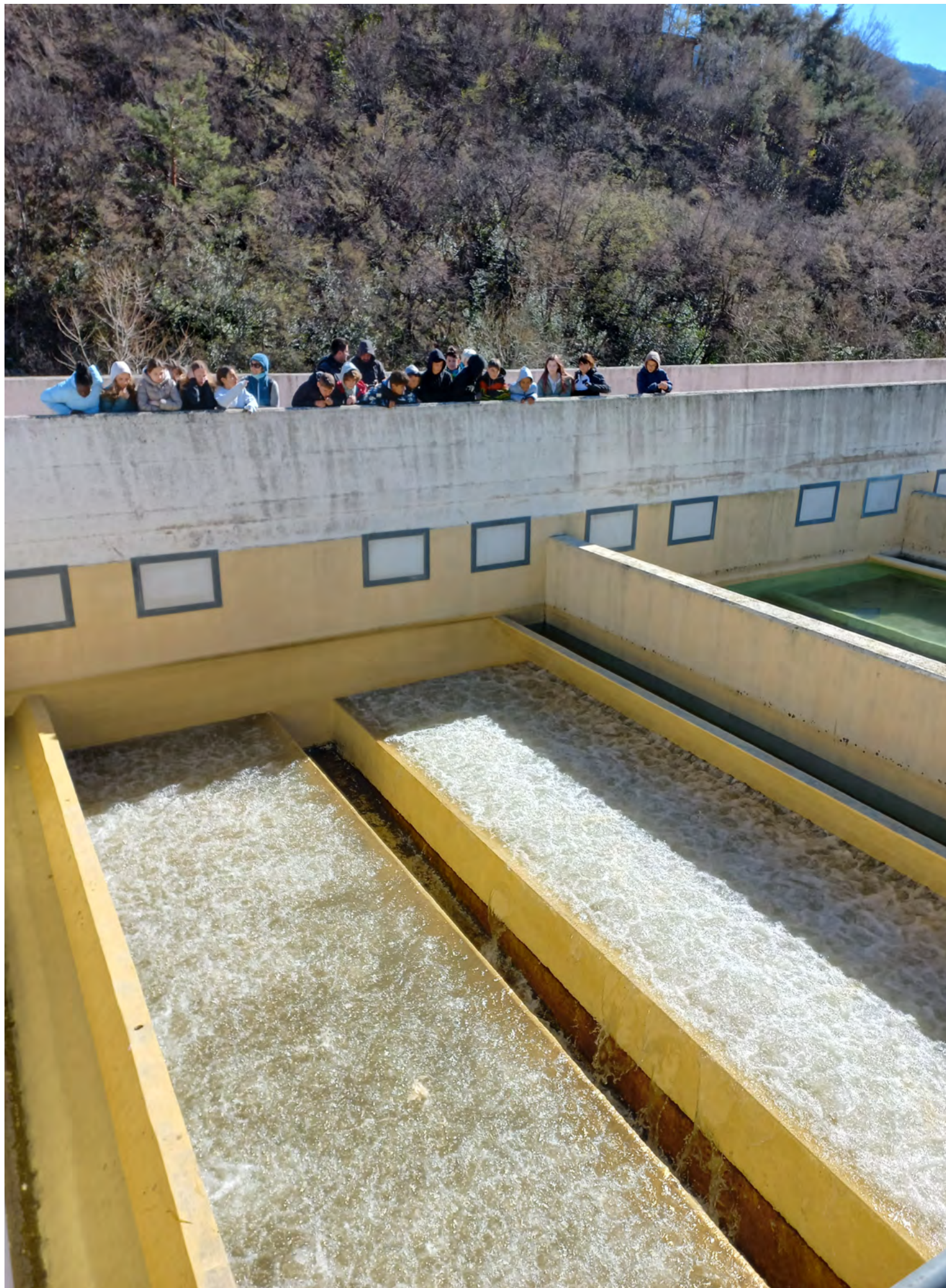
Scolaresca in visita al Potabilizzatore di Valmadrera.
