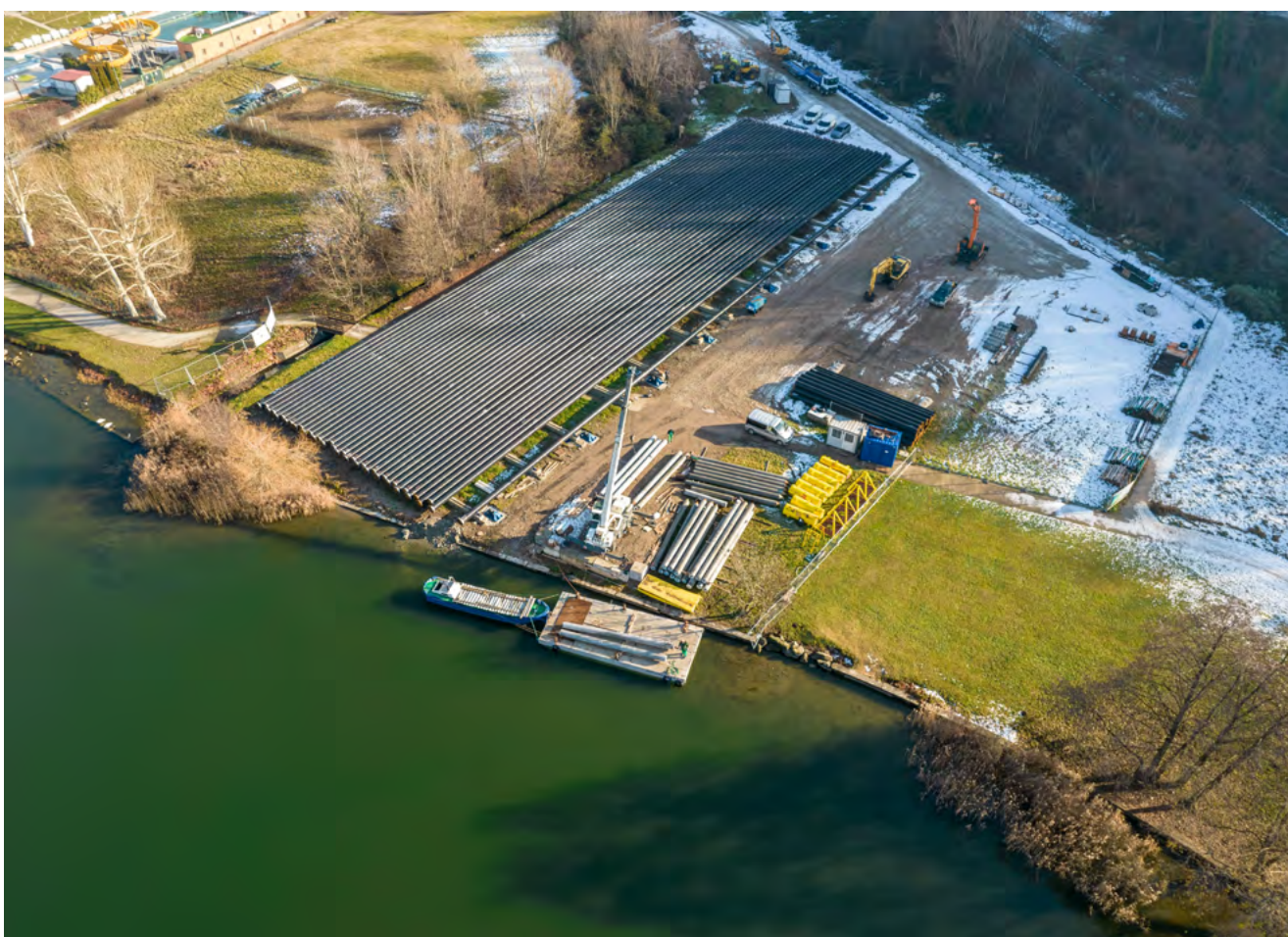
Acquedotto Brianteo, varo del tratto sublacuale nel Lago di Annone. Foto di Matteo Colombo.
