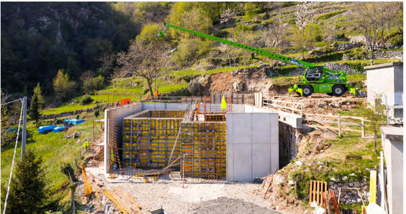
Costruzione del nuovo serbatoio Belvedere a Valmadrera (2023). Foto di Matteo Colombo.
