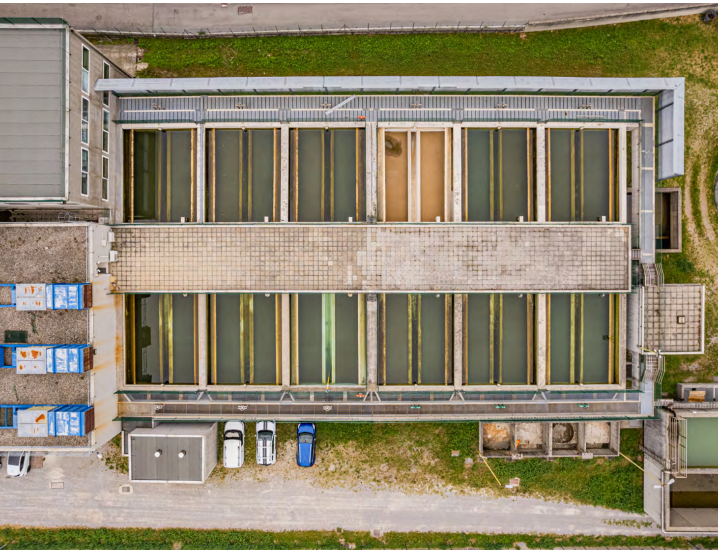
Potabilizzatore di Valmadrera, Parè. Foto di Matteo Colombo.
