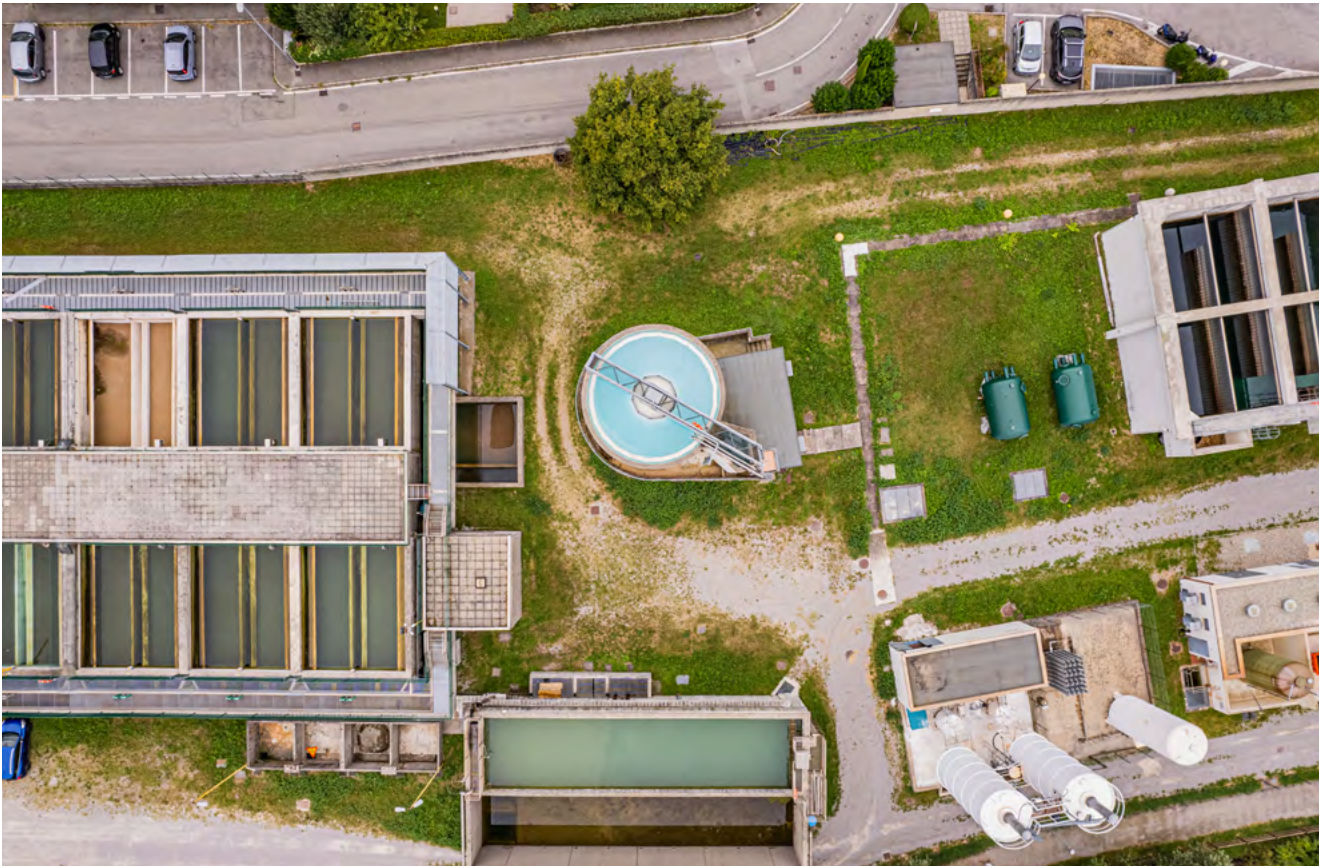
Potabilizzatore di Valmadrera. Foto di Matteo Colombo.
