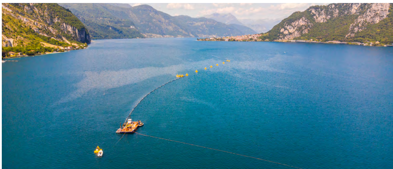
Varo della tratta sublacuale del collettore fognario verso Parè, Valmadrera. Foto di Matteo Colombo.
