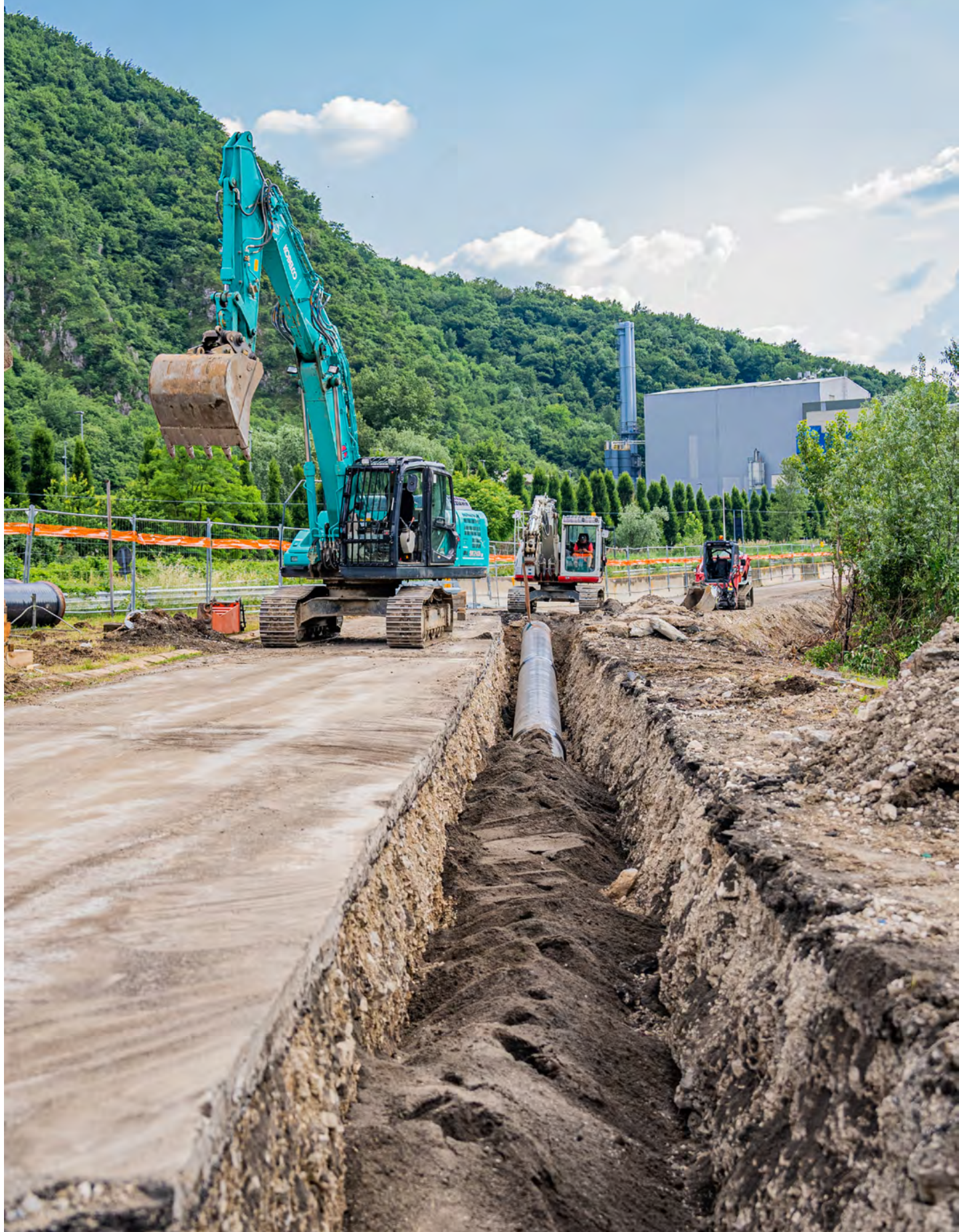
Raddoppio dell'Acquedotto Intercomunale Brianteo, Valmadrera. Foto di Matteo Colombo.
